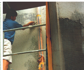
19. ábra. Példa vakolaterősítő háló használatára
