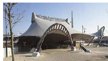
Textilanyag burkolatú könnyűszerkezetes épület
