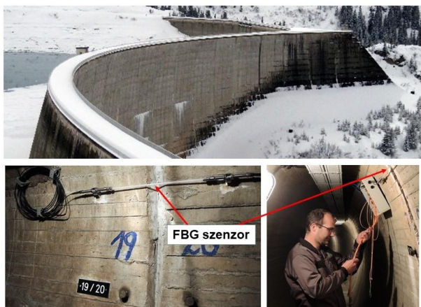
FBG érzékelővel monitorozott gát Ausztriában
