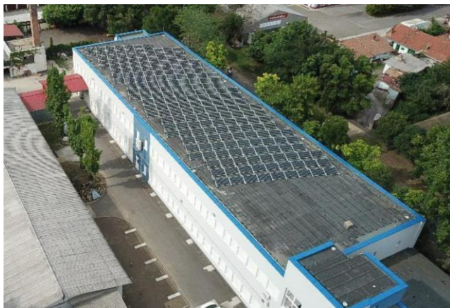
Az 50 kW-os napelemrendszer a békéscsabai üzemcsarnok tetején
